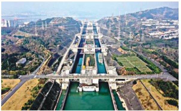
船舶通过三峡船闸。（资料图）汤伟 摄
